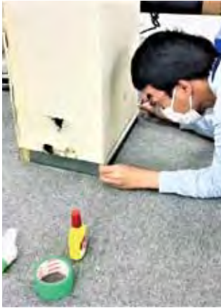
壁の修理はおまかせ 西田 賢一 (大阪府) 株式会社キリンドゥベスト
